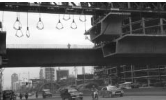
Abb. 1 Bau einer Segmentbrücke
