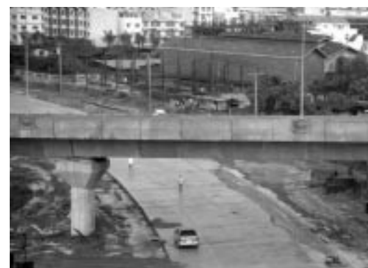
Abb. 7: Fertiggestellte Segmentbrücke
