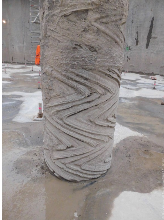
Abbildung 4.2: Mantelfläche eines mit oszillierend gezogener Verrohrung hergestellten, freigelegten Bohrpfahles an der Schleuse Zerben (Bundesanstalt für Wasserbau 2020)
