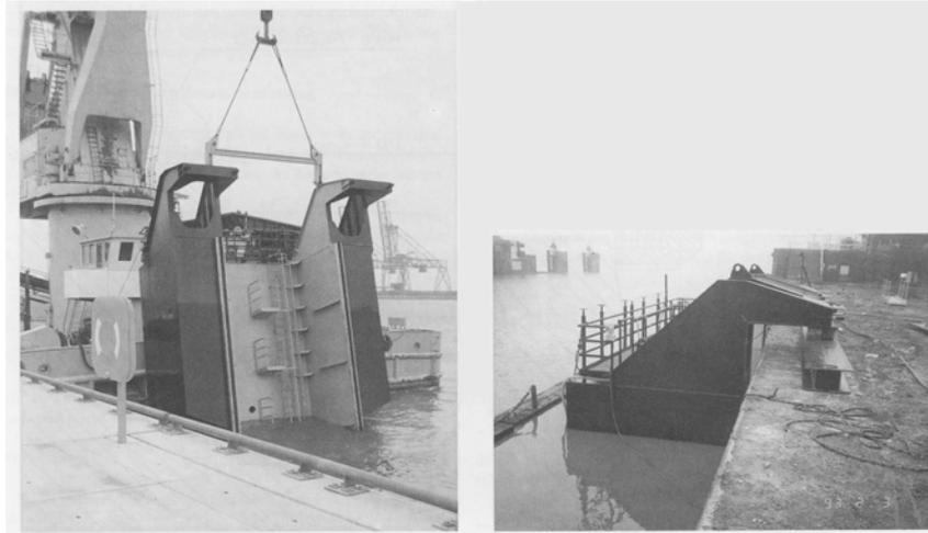
Abbildung 1.2.: Einhängen eines Süllkastens (links) und eingehängter Süllkasten (rechts) aus [6]
