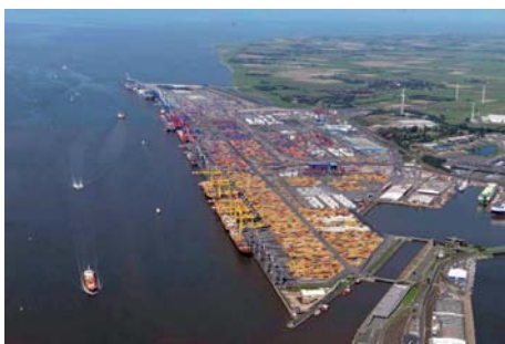
Bild 2.14: Weltweit längste Kaianlage am Containerterminal Wilhelm Kaisen in Bremerhaven (© bremenports)
