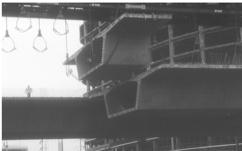
Abb. 5.1: Segmentbrücke im Bauzustand
