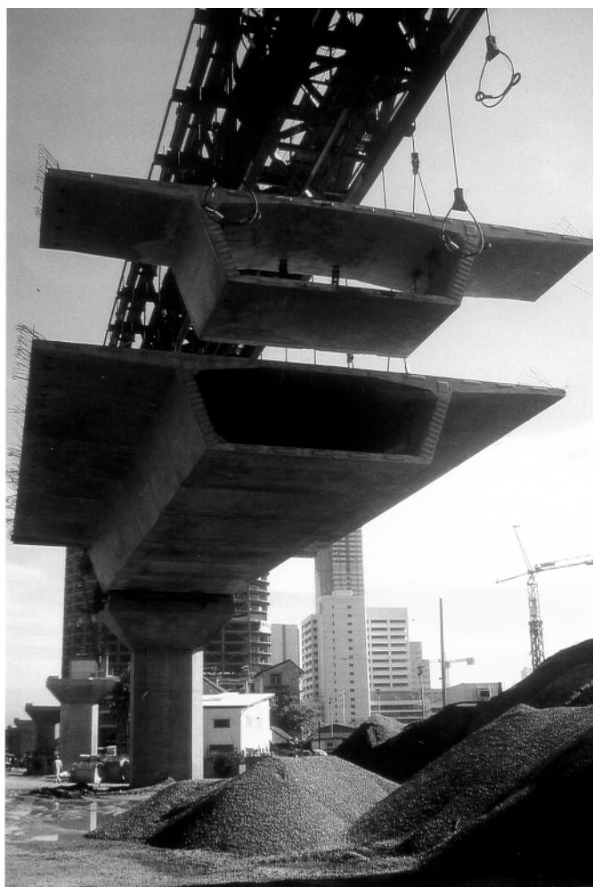
Abb. 1.1: Segmentbrücke des „Second Stage Expressway“ in Bangkok
