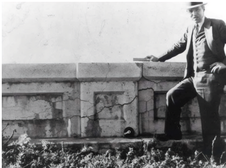
Abbildung 1.1: T. E. Stanton an einer Wand mit einem AKR-Schaden, aus [2].
