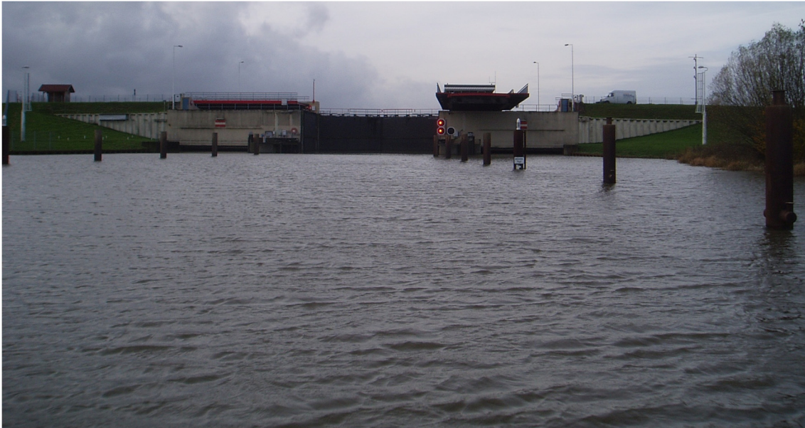
Abbildung 36: Das geschlossene Krückau-Sperrwerk, Blick in Richtung Elbe
