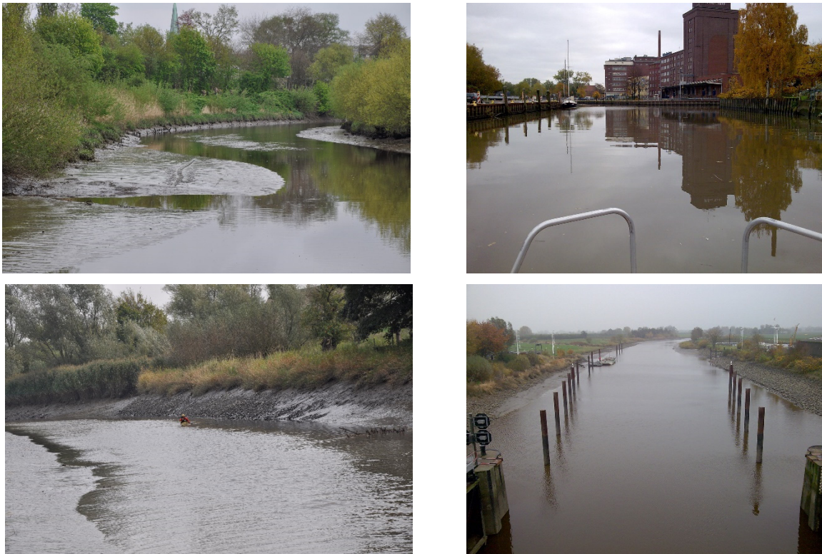
Abbildung 47: Typische Uferbeschaffenheiten am Unterlauf der Este: Röhricht und Buschbewuchs beim Segelhafen Elmshorn (oben links), Spundwände im Elmshorner Hafen (oben rechts), Steinschüttung bei Seester (unten links), Steinschüttungen im Sperrwerksbereich (unten rechts)
