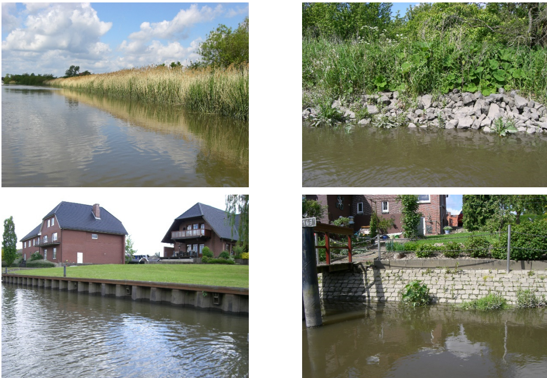
Abbildung 46: Typische Uferbeschaffenheiten am Unterlauf der Este: Röhricht bei Buxtehude Neuland (oben links), Steinschüttung (oben rechts), Spundwand bei Hove (unten links), Sohle bei Estebrügge (unten rechts)
