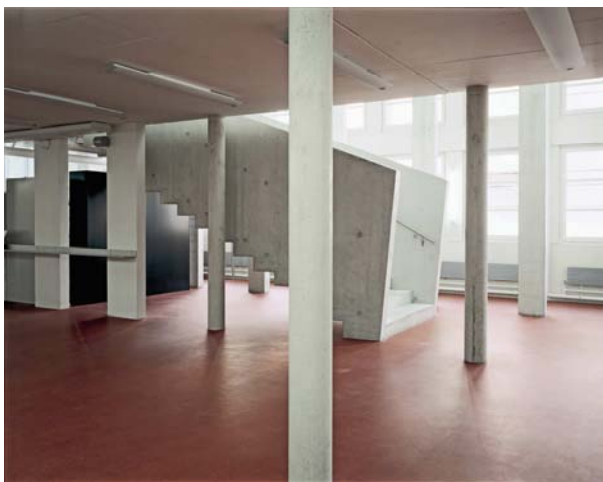
Alt und neu vereint: Gut sichtbar sind im Hauptgebäude der Nationalbibliothek der grobe Beton der Stützen und Decke von früher und der feine Sichtbeton der Stützen und Treppen von heute. (Fotos: Marco Schibig, © Bundesamt für Bauten und Logistik)
