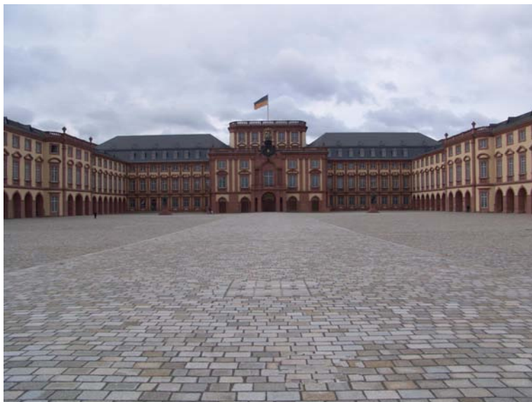
Schloss Mannheim – Mittelbau (Foto: UB Mannheim)
