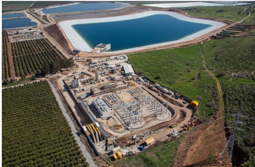
Bild 15: Kraftwerk mit unterem Wasserreservoir [12].
