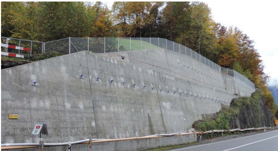
Bild 16: Ansicht der ertüchtigten Stützwand mit zwei Ankerreihen (Nov. 2021)
