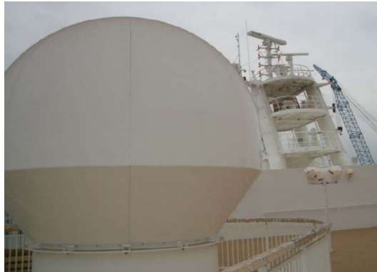
Bild 10: Radom mit Satellitenantenne (v.l.) und Radaranlage (auf Mast)
