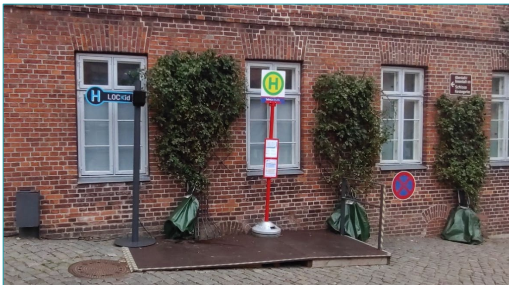
Abbildung 10-3: Entwickelter Haltestellenpodest am Kirchplatz in Lauenburg/Elbe aus Holz (eigene Aufnahme)
