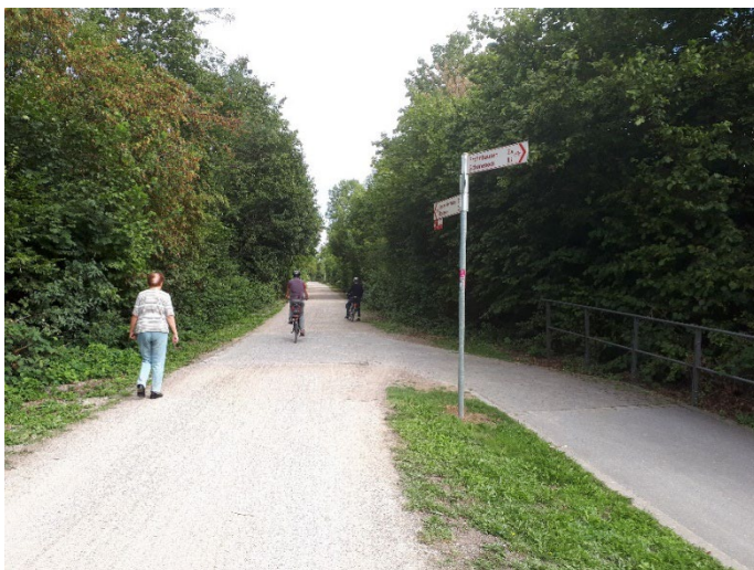
Abbildung 37: Teilabschnitt des RS1 von der Hamborner Straße bis zur Essener Stadtgrenze
