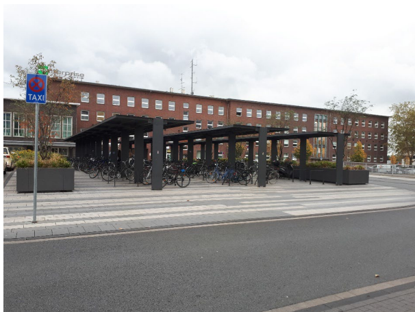
Abbildung 28: Fahrradgroßparkplatz am Duisburger Hauptbahnhof
