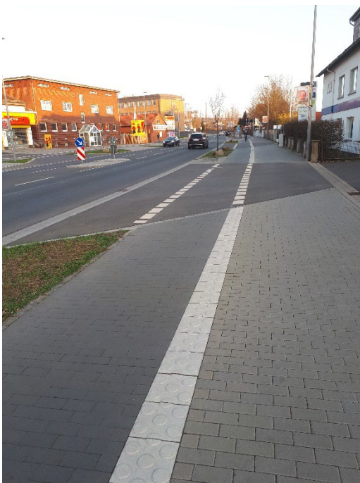
Abbildung 10: Von der Kfz-Spur durch einen Grünstreifen getrennte Radverkehrsführung im Seitenraum der Straße
