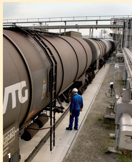
Monatlich 800 Kesselwagen (Foto 1) sowie Container und Tankkraftwagen werden in der Tankstation mit Basischemikalien befüllt (2). Der Rangierbahnhof hat ein 16 Kilometer langes Gleisnetz (3).
