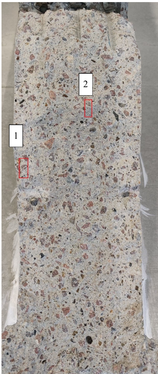
Bild 432 Übersicht der oberen Rissoberfläche
