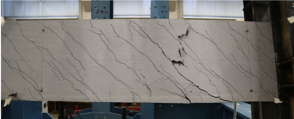
Bild 315 B12 Versagen im Bereich der Lasteinleitung
