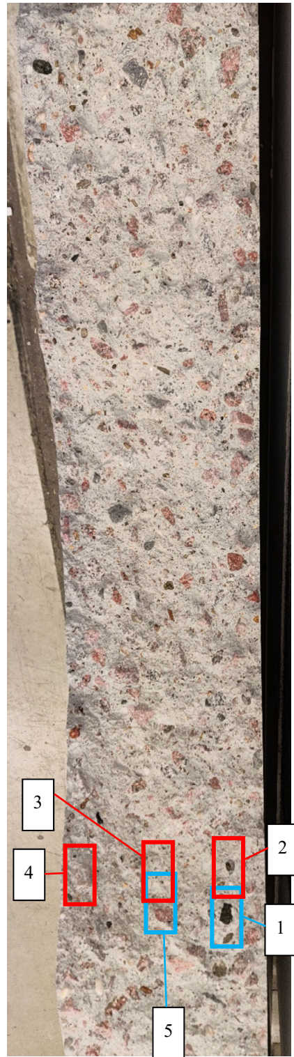
Bild 350 B1.1 Rissoberfläche Oberseite
