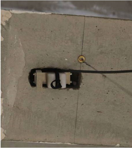
Bild 35 DD1 unterhalb der Lasteinleitung
