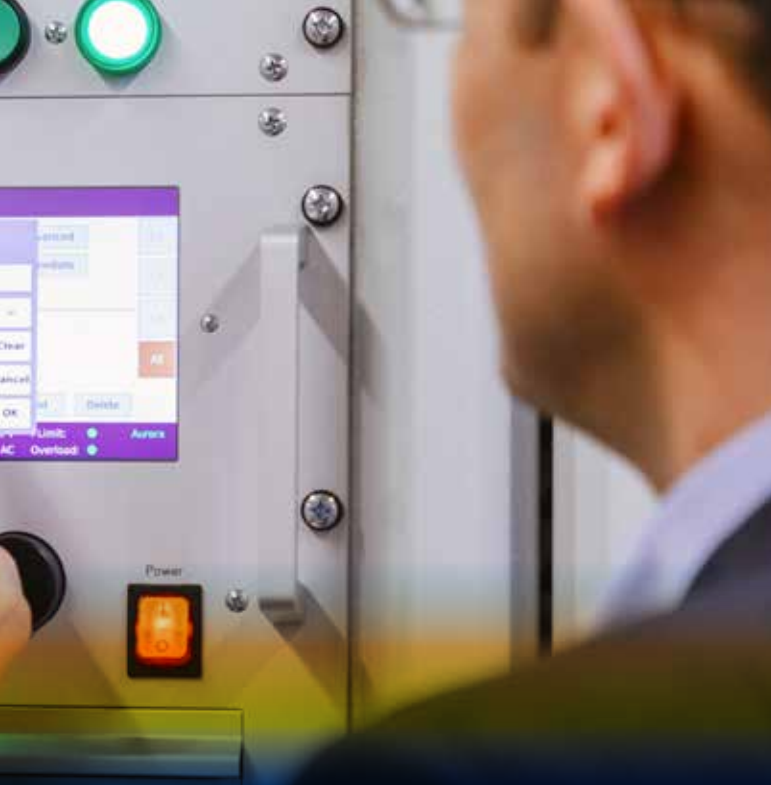
Für ein sicheres Netz: Der Schaltschrank beherbergt Elektrik und Elektronik des Projekts
