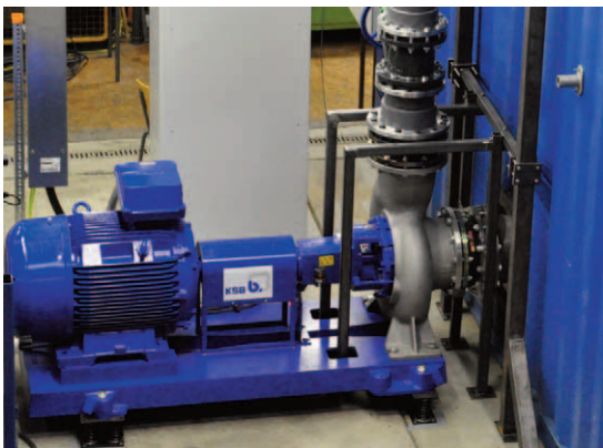
Bis zu 1,3 Millionen Liter Wasser pro Stunde können mit einer Kreiselpumpe (links) umgewälzt und durch einen Wärmeaustauscher (rechts) in den 30 000 Liter fassenden Wassertank (oben) zurückgepumpt werden.
