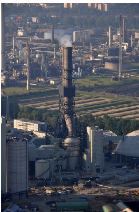
Schornstein des Dampfkraftwerkes in Moorbург: Hier werden bis zu 480 t Steinkohle pro Stunde verbrannt.
