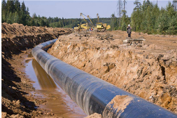
ABB. 3.13: Errichtung einer Erdgaspipeline ( National Parks Conservation Association, 2007 )
