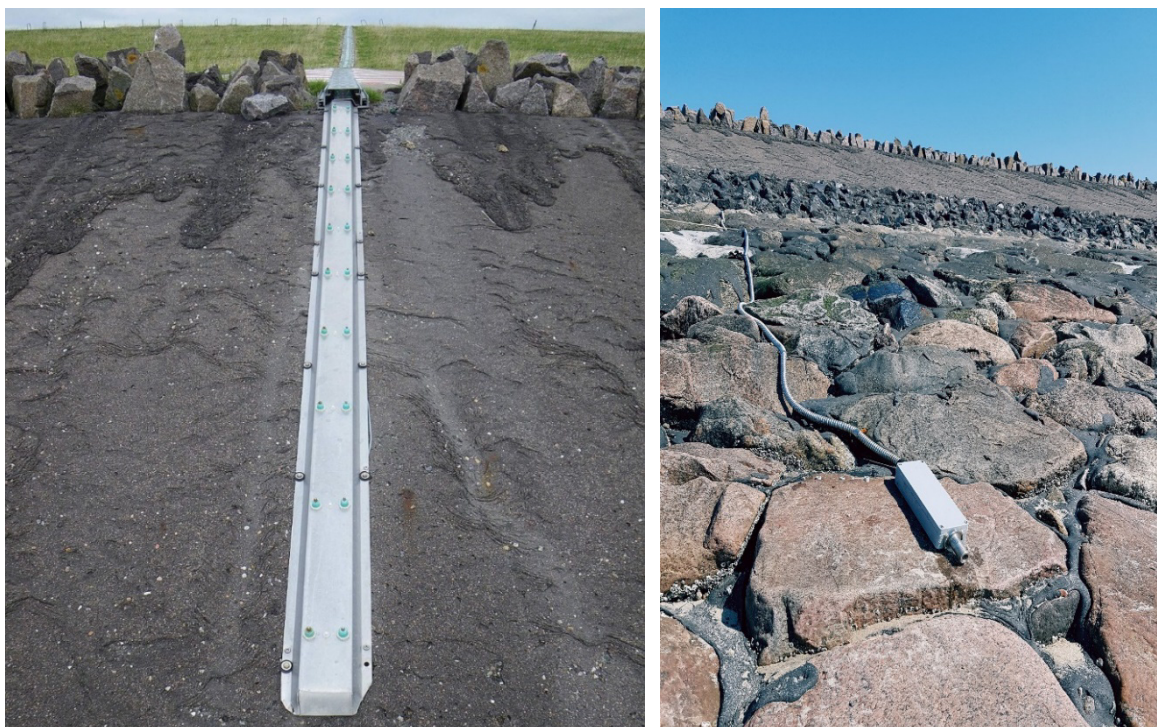
Abbildung 5: Links: Wellenauflaufpegel „Untjehörn“ des LKN-SH, rechts: fest installierte 10 Hz-Druckmesssonde am Deichfuß.
