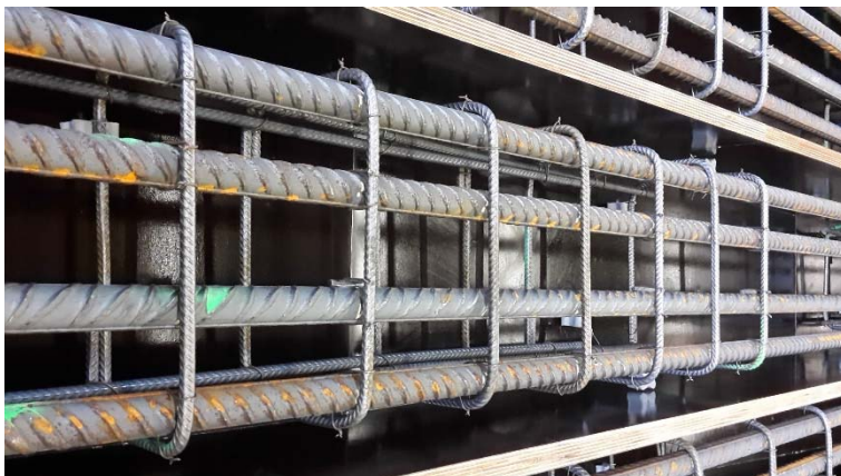
Bild 8 Oberen Bewehrung von Balken T3
