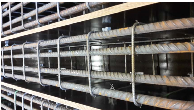
Bild 11 Obere Bewehrung von Balken T5
