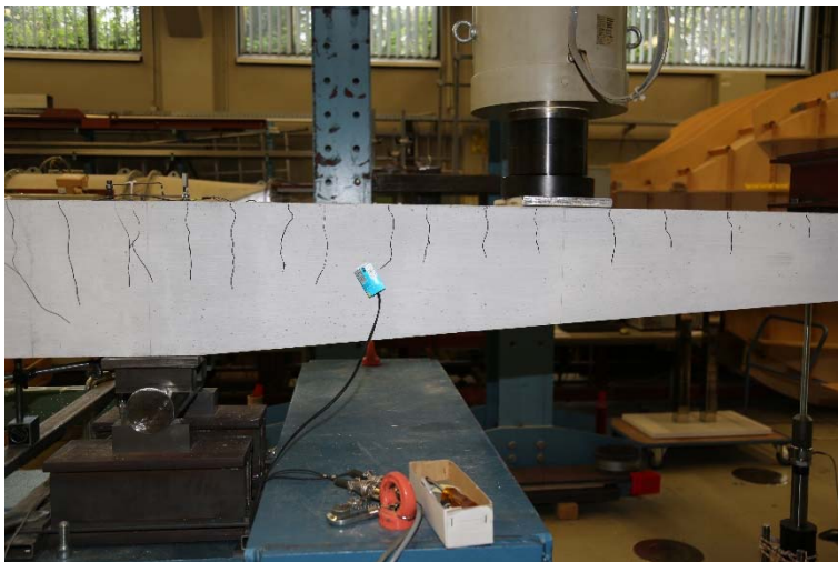
Bild 35 Balken T4 - Rissbild bei einer aufgebracht Last von 75 % von F_2
