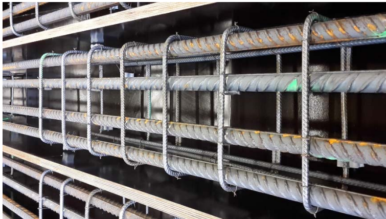
Bild 5 Obere Bewehrung von Balken T1
