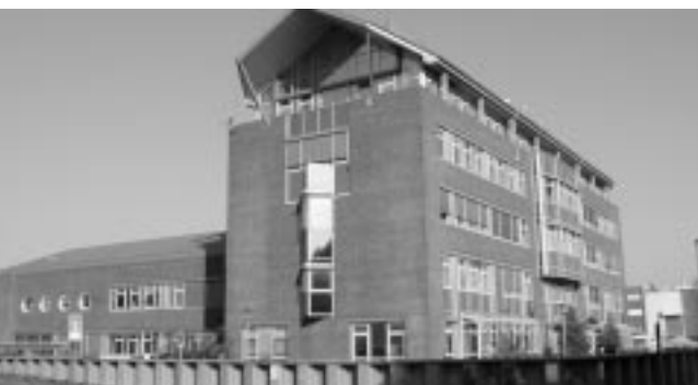
Abb.1 Technologiezentrum Hamburg- Finkenwerder
