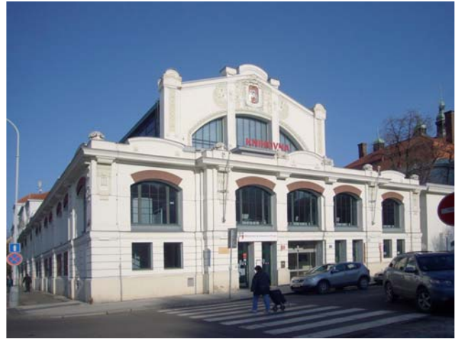
Abb. 12: Die frühere Markthalle umgebaut zur Bibliothek, Zweigstelle Smíchov/Stadtbibliothek Prag (Foto: Feldsien)
