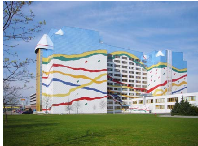
Abb. 15: Die farbig gestaltete Fassade des Nationalarchivs der Magazintürme, Prag (Foto: Feldsien)
