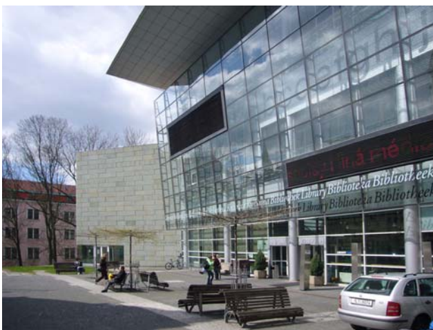
Abb. 6: Fassade mit Synagoge (links in Stein) und der verglasten Bibliothek, Regional Research Library/Liberec (Foto: Feldsien)
