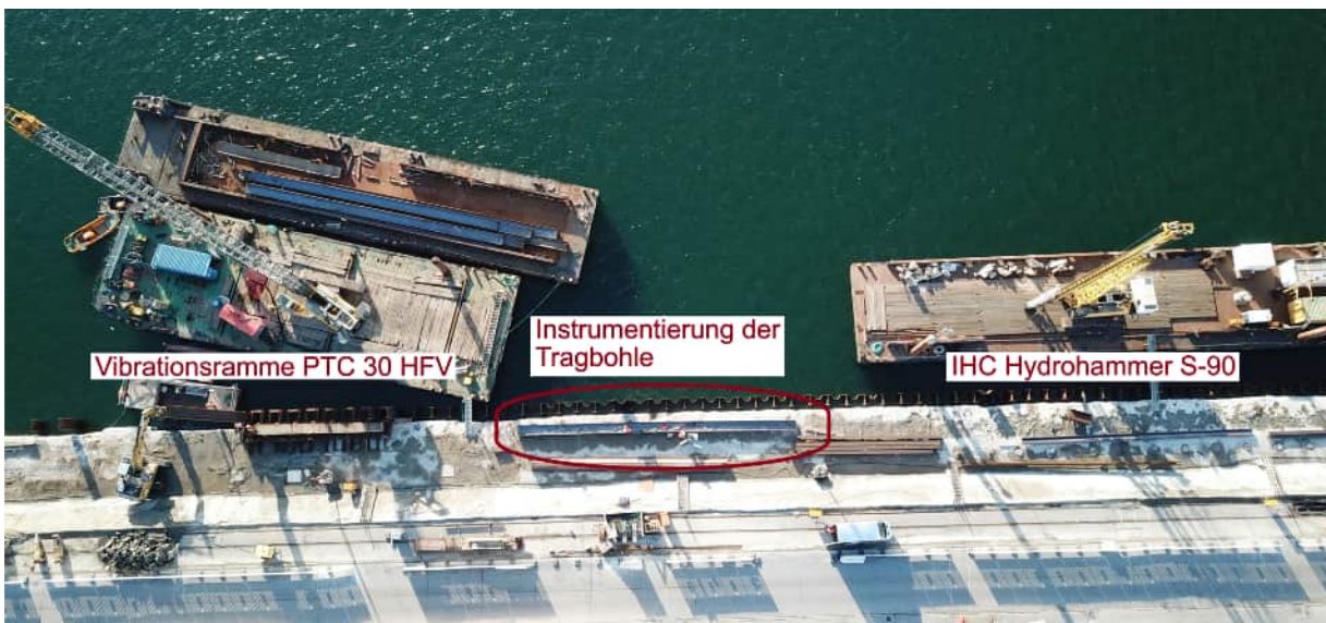
Abb. 5.2: Luftaufnahme mit dem Ponton zur Vibrationsrammung (links), der Sensor- montage (Mitte) und dem Ponton zur Schlagrammung (rechts). Foto: J. Beußé
