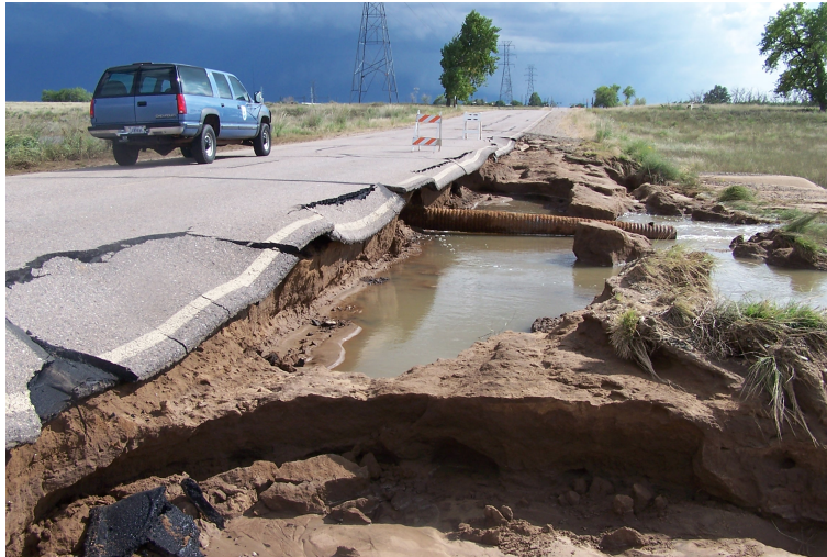
Abbildung 1.2: Straßenschäden nach einem Starkregenereignis und damit einhergehender Überschwemmung im Rocky Mountain Arsenal National Wildlife Refuge, 2013. C St. - Rocky Mountain Arsenal NWR von „USFWS Mountain-Prairie“, Lizenz: CC BY 2.0.
