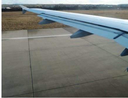
Bild 1: Start- und Landebahn des Flughafens Stuttgart-Echterdingen mit Unebenheiten an den Übergängen der dort verwendeten Betonplatten
