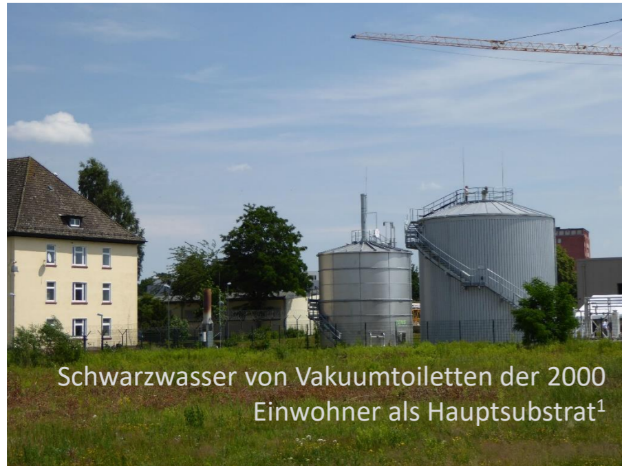
Kleine Biogasanlage für Schwarzwasser in der Jenfelder Au / Wandsbek
